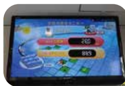
施設玄関にあるモニターでは発電量が一目瞭然
