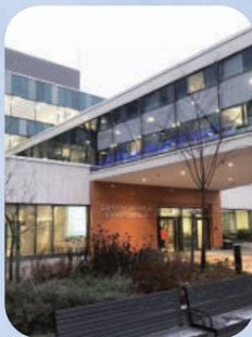
▲エスポー病院 外観
